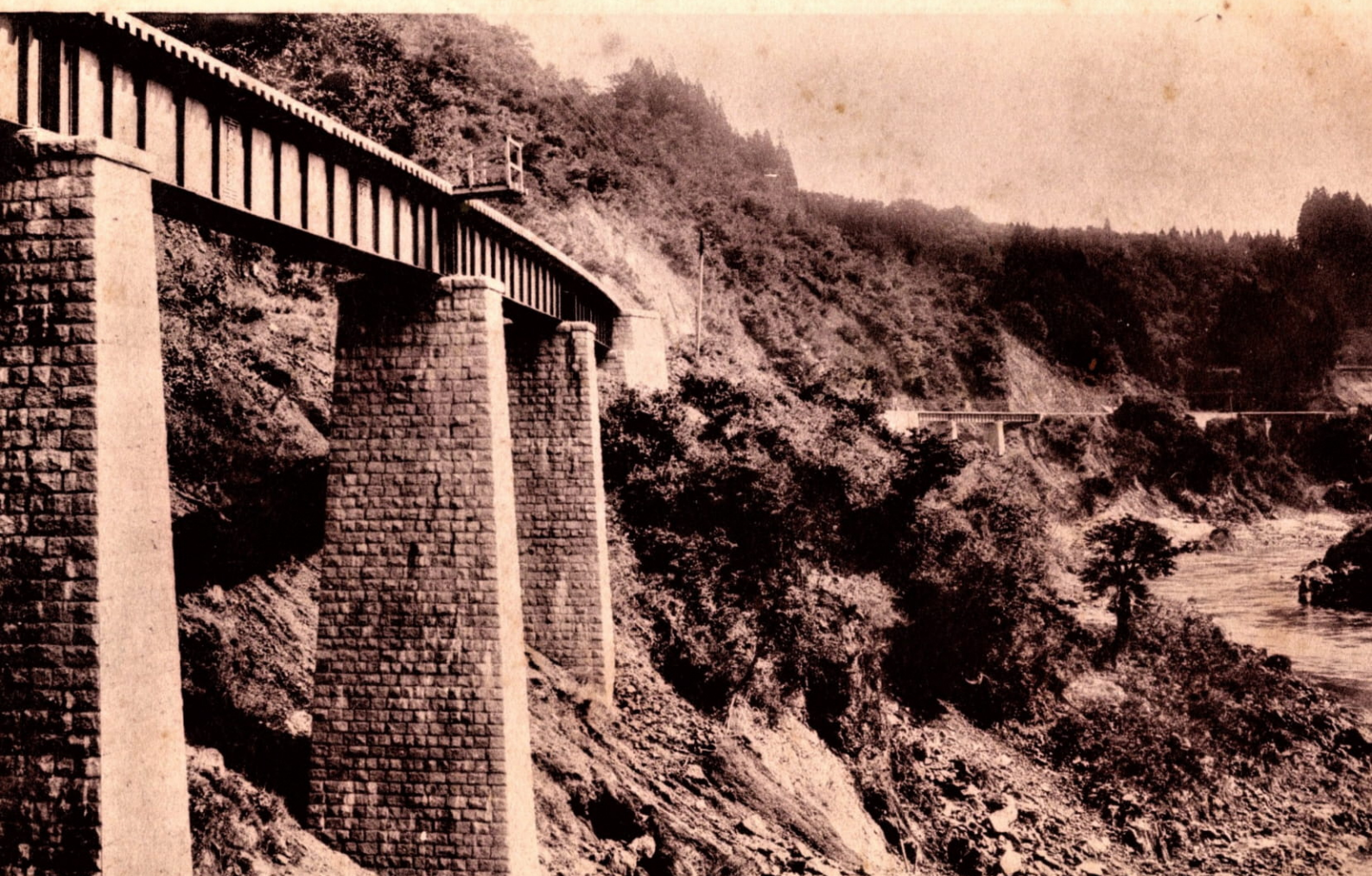
岩越線大巻橋梁附近
